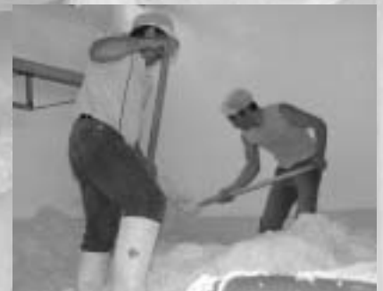
In de stenen put wordt de kool verdeeld en door mensen aangestampt.
